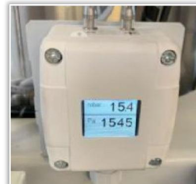
Überwachung Filterzustand (DDMU)
