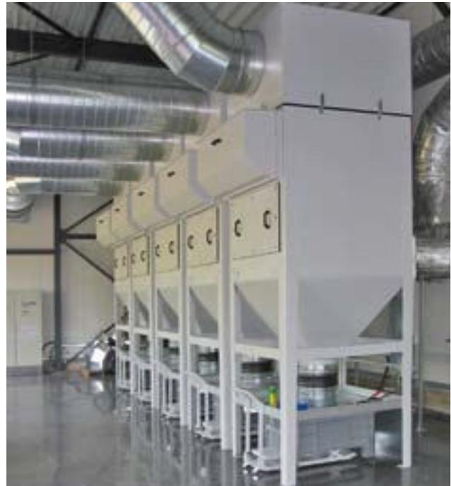
*Absaug- und Filtertechnologie vom Typ ASD kann auch die zentrale Lösung für ganze Werkhallen sein.*
