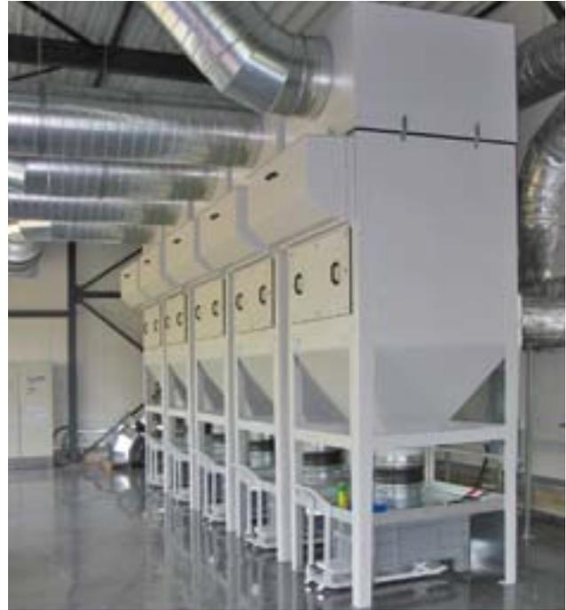
*Absaug- und Filtertechnologie vom Typ ASD kann auch die zentrale Lösung für ganze Werkhallen sein.*
